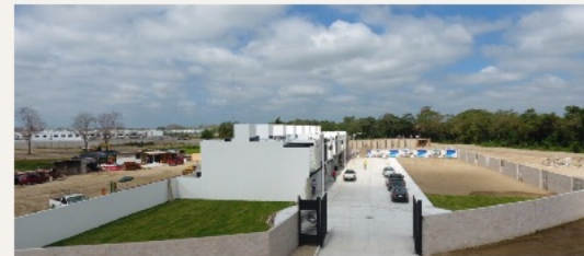
Acceso y vialidad · etapa de obra
