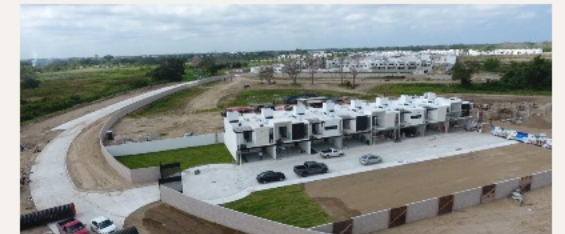
Vista aérea · etapa de obra
