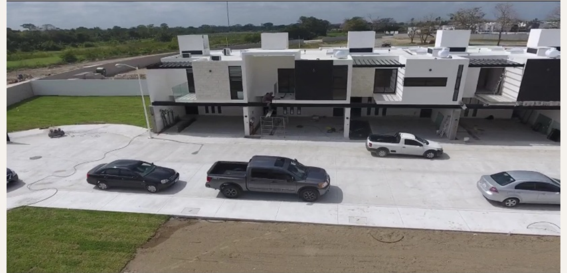
Viviendas y vialidades · etapa de obra
